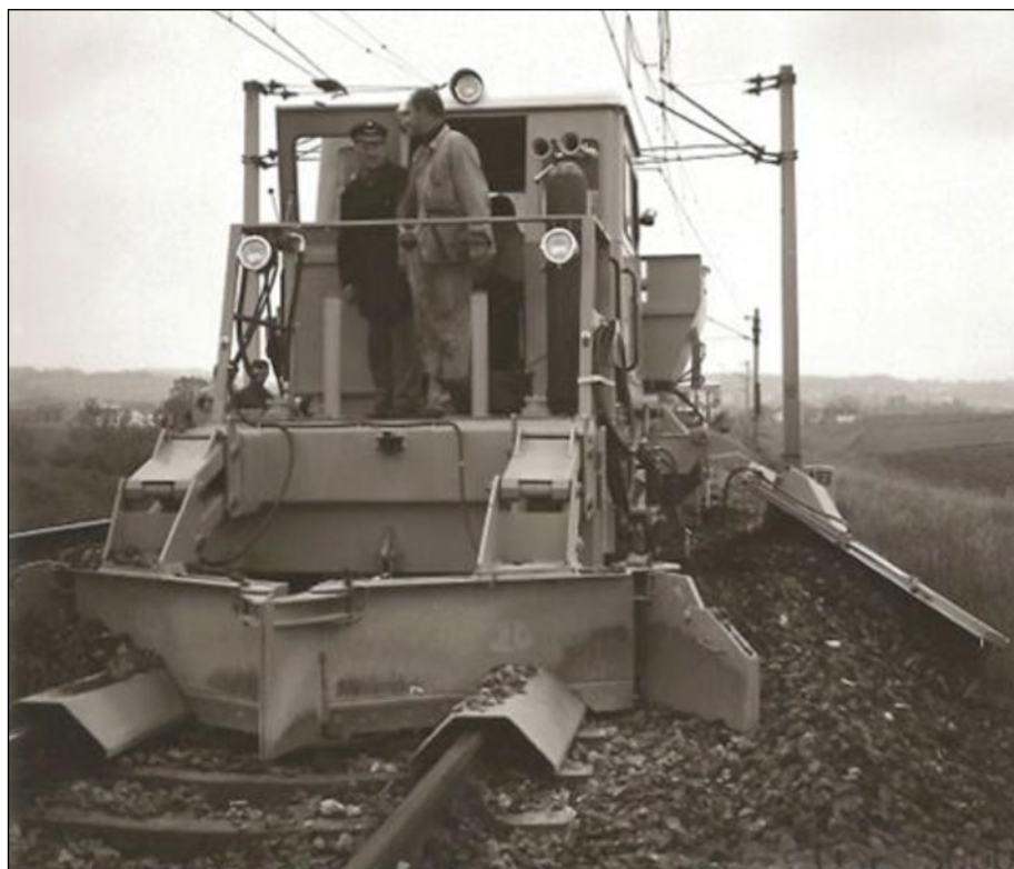
Abb. 1: Schotterverteiler- und Planiermaschine
